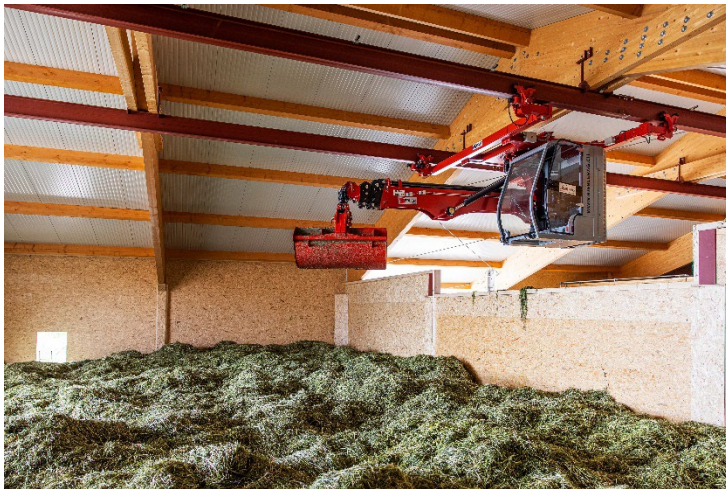
Abbildung 10: Heukran über der großen Box, rechts die Trennwand zur nächsten Box
