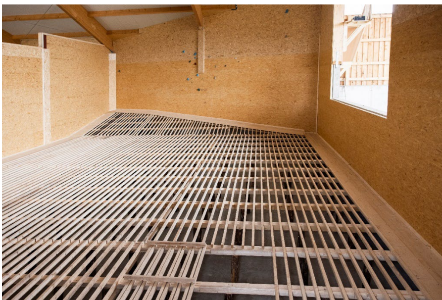
Abbildung 9: Rostboden in einer der Heuboxen bei Vorwerk Podemus
